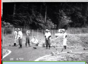
有害獣柵補修
