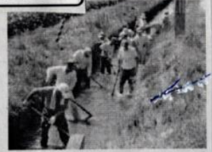
水路の泥上げ
