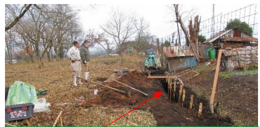
令和2年2月14日 ルートカット埋め込み作業（長さ20.m×幅60 cm）
